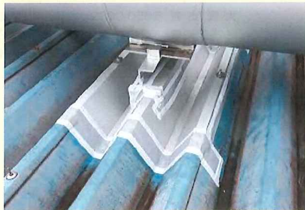
建屋屋根の雨漏り防止用に活用された例 (イヌバテープ併用)
