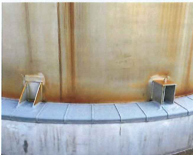
小規模タンクでモルタル土台側面までカバーした施工例 北海道苫小牧市 新酸素化学株式会社様
