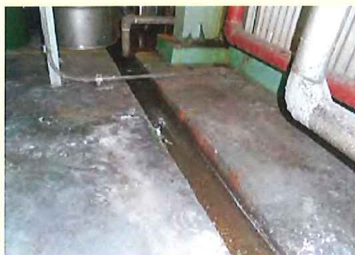
工場建屋内コンクリート排水溝の補修例
