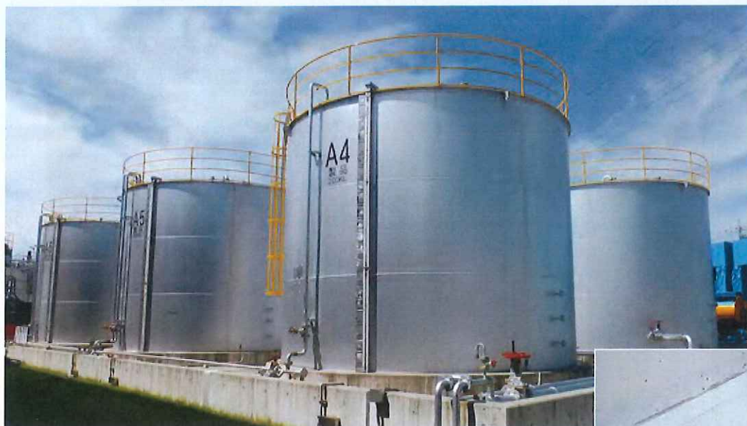
小型タンクでモルタル土台にシーラントマスター300-Gを併用した施工例 愛知県知多市 ユーザー様
