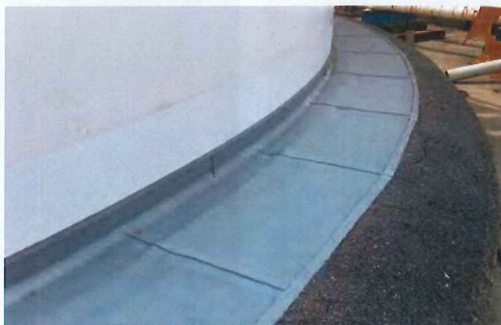
タンク側面への立ち上げを付けた施工例 神奈川県川崎市 油槽所様
