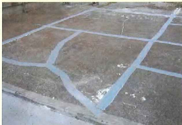
陸屋根の雨漏り防止の補修例
