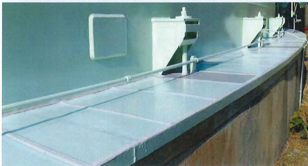
金属製カバーの防食用にイヌバシール、パッチシールクロスとイヌバテープを用いた施工例 愛媛県今治市 ユーザー様
