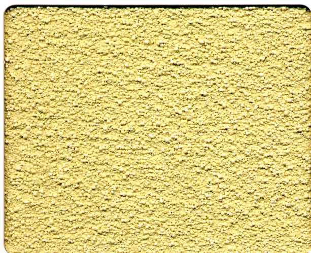
刷毛引き仕上げ
