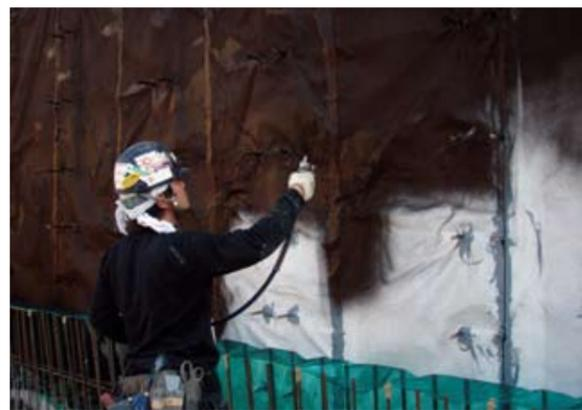
先やり工法では、レンペキルーフに吹付けにより施工をします。写真はレンペキルーフ（先やり工法）への吹付けの様子。下地に凹凸があっても作業が可能です。
