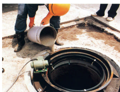
マンホール回り(モルタル)
