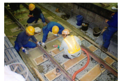
軌道下バラスト補強(グラウト)
