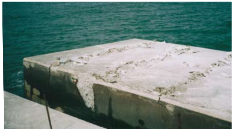
防波堤の破碎 実孔径42mm 孔間隔350mm
