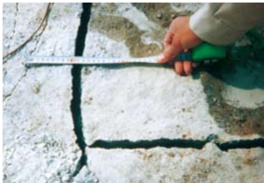
急傾斜岩盤の破碎 実孔径42mm 孔間隔300mm
