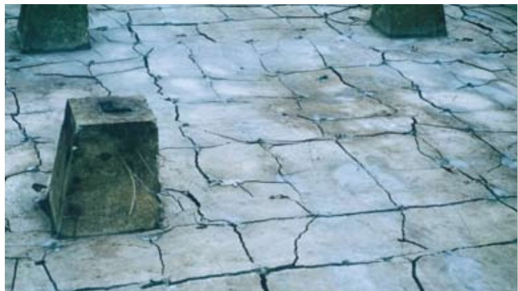
鉄塔基礎コンクリートの破碎 実孔径44mm 孔間隔450mm
