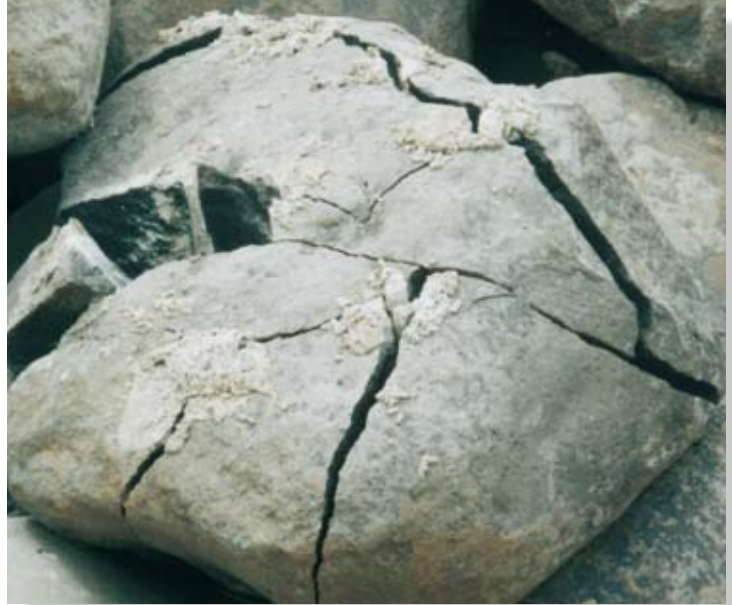
転石の破碎 実孔径42mm 孔間隔350mm
