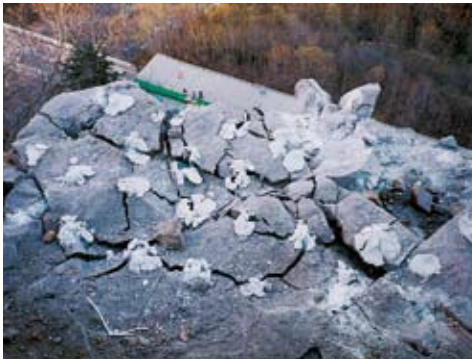
急傾斜岩盤の破碎 実孔径42mm 孔間隔300mm
