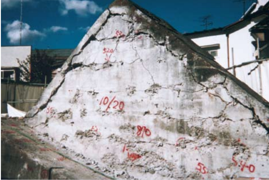
基礎コンクリートの破碎 実孔径42mm 孔間隔400mm
