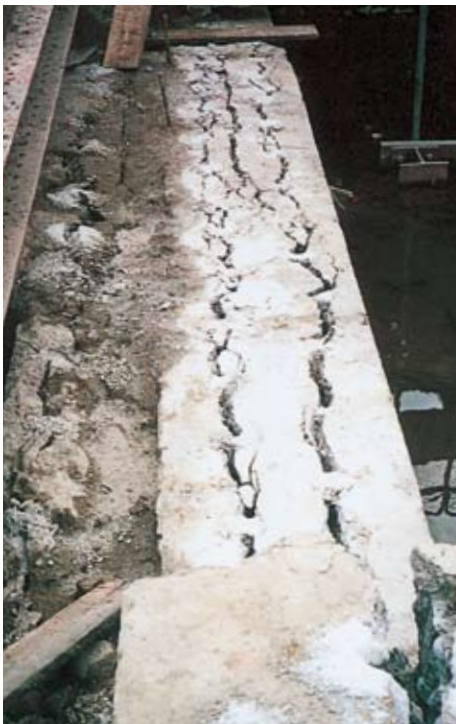
仮設構造物の破碎 実孔径42mm 孔間隔400mm
