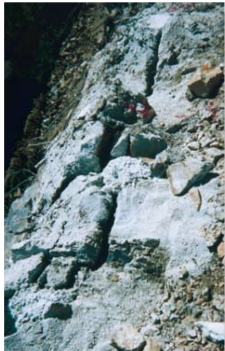
岩盤の破碎（ベンチカット） 実孔径67mm 孔間隔650mm
