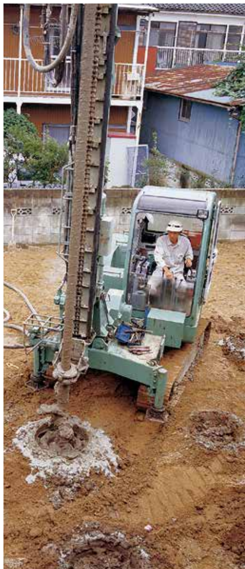
ソイルセメントコラム工法
