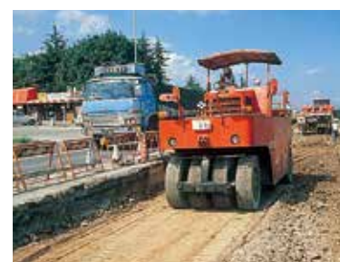
改良手順5 (転圧)
