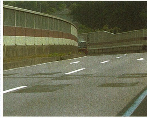
道路ジョイント部
