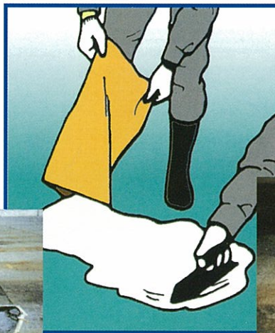
打設・コテ均し
