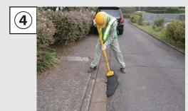
タンパなどで十分に締固めま ※プレートにて締固めるとよ
