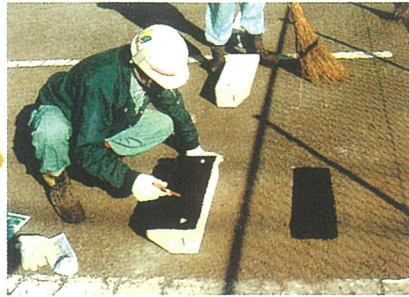
②接着剤の塗布 清掃が終わり次第ブロック設置位置を決めて下さい。ブロック設置場所が決まり次第、接着路面とブロック底面それぞれにシステムロードを塗布して下さい。点付不可。
