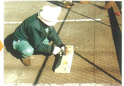
③ブロック据付、養生 システムロード塗布後、上から押し付けるように乗せて下さい。はみ出したシステムロードを除去して、作業は完了です。
