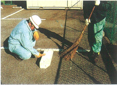
①接着面の清掃 接着面のホコリ・油・汚れ・ごみ・水溜まり等、接着剤塗布前に完全に除去して下さい。
