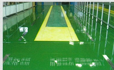
トラック整備工場(塗り床下地)
